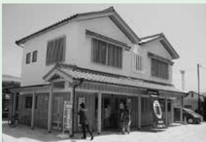
木材を利用した公共建築物 (伊勢市駅手荷物預かり所)
